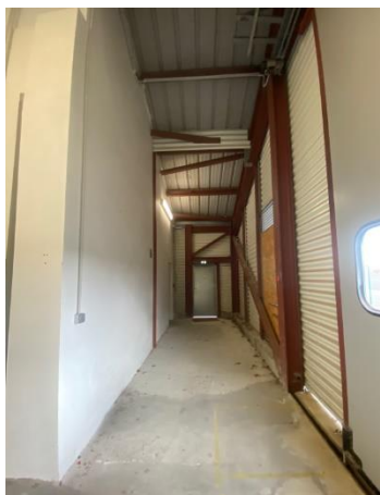
Un couloir de 16,25 m 2 qui dessert le bureau
