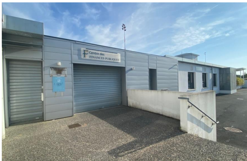
Façade Nord Entrée côté ville
